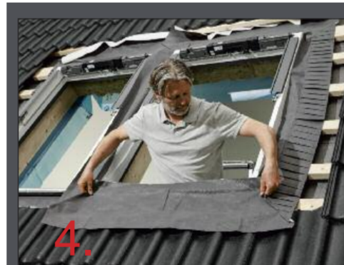
Auf der äußeren Seite werden die Anschlussschürzen wie bewährt plissiert sein; der zwischen den Dachfenstern liegende Bereich wird für eine leichtere Verarbeitung künftig glatt gefertigt.
