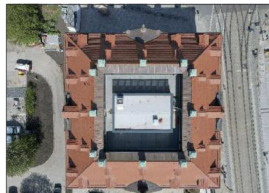
Der für die Aufnahme des Archivs der Avantgarden in das Gebäudeinnere eingefügte, massive Betonkubus endet 3,5 Meter unterhalb des Dachfirstes. Der Raum zwischen Lichthof und Dach wurde mit Dachbahnen aus FPO (flexiblen Polyolefine) abgedichtet.
