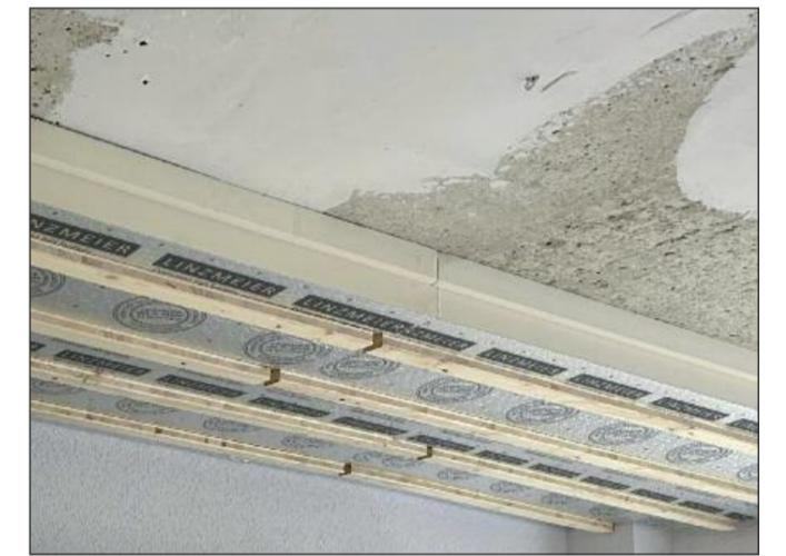
Neben der kurzen Montagezeit bietet die neue Innendämmung LINITHERM PAL UK eine minimale Aufbauhöhe dank hoher Dämmeffizienz ( \lambda 0,023). Die raumseitige Beplankung ist frei wählbar, die elektrische Ausstattung (LED-Spots, Steckdosen etc.) lässt sich schnell und sicher einbauen oder nachrüsten.
