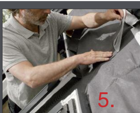
Mit dem im Lieferumfang enthaltenen Klebeband lassen sich die übereinandergelegten, glatten Schürzen ganz einfach und sicher abdichten.
